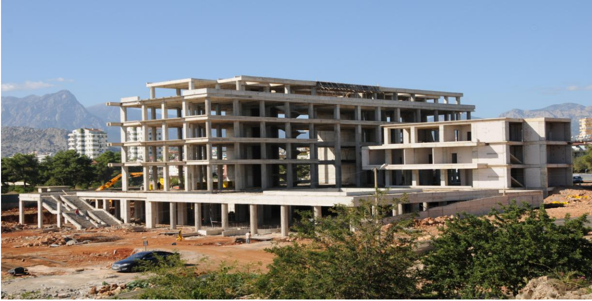
Yapımına devam edilen hizmet binamızın inşaat aşaması
