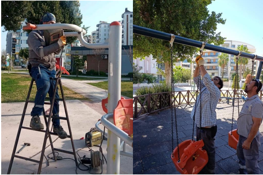
Bakım onarım çalışmaları
