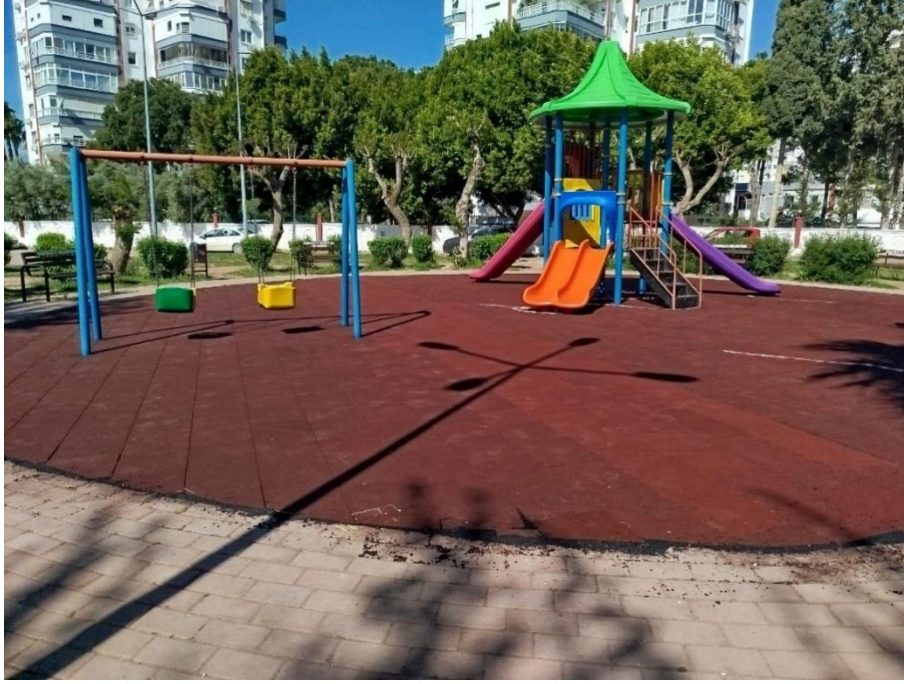
Şehit Komiser Muammer Turgut Parkı çocuk oyun alanı zemini kauçuk yenilemesi
