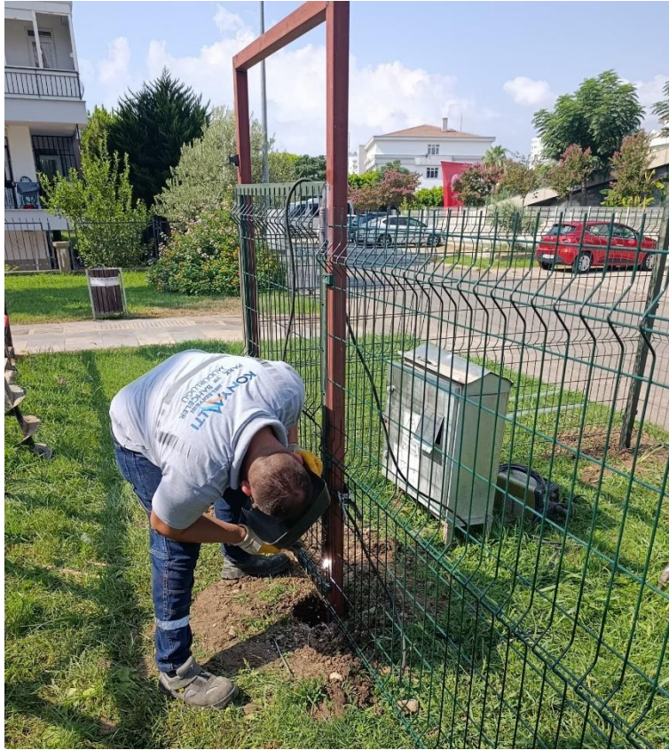
Demir-kaynak ekibi bakım onarım uygulaması
