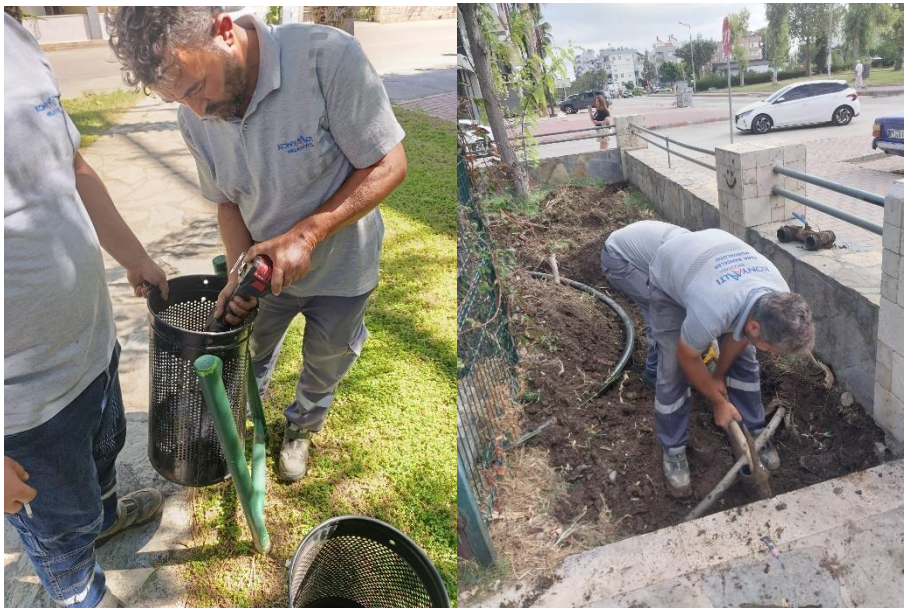
Bakım onarım çalışmaları
