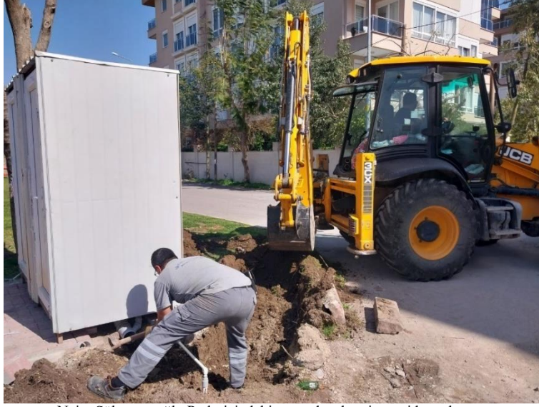
Naim Süleymanoğlu Parkı içindeki wc ve lavabo pis su gider çalışması
