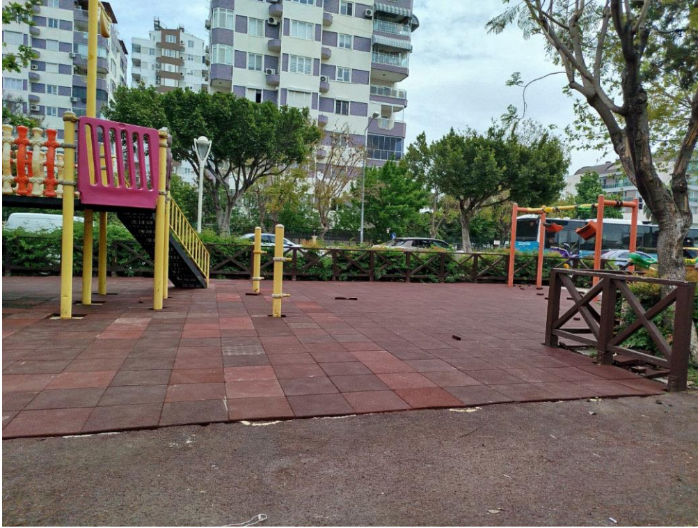
Emek Parkı1. Kısım çocuk oyun alanı zemini kauçuk yenilemesi
