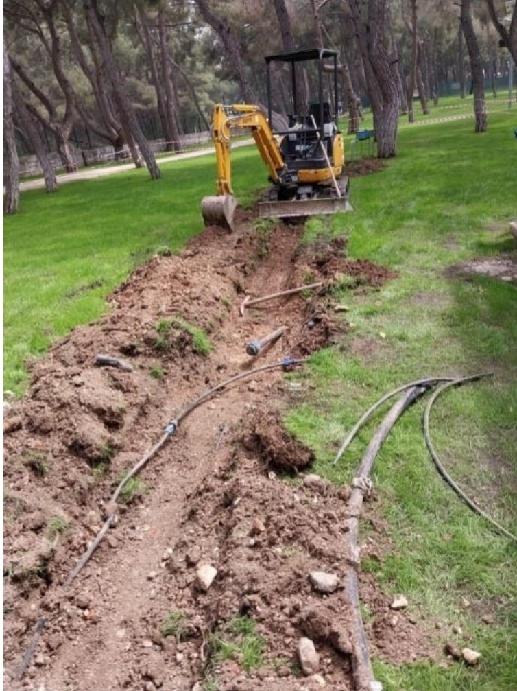
Hayat Parkı içinde bulunan wc'ye şebeke suyu çekimi çalışması
