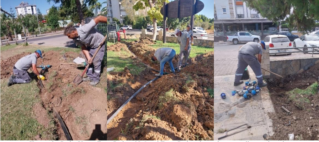
Kaymazlar Parkı, Yunus Emre Parkı ve N. Sevgi Taner Parkı sulama alt yapı yenileme çalışmaları
