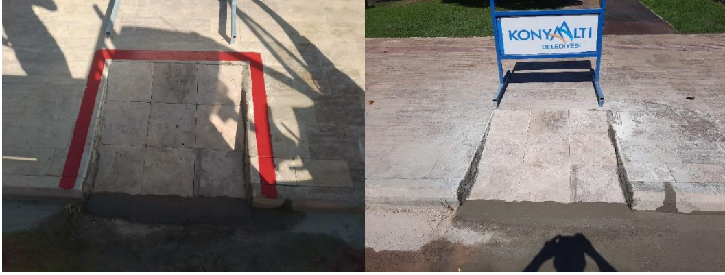
Emek Parkı 2.Kısım rampa yapım çalışmaları
