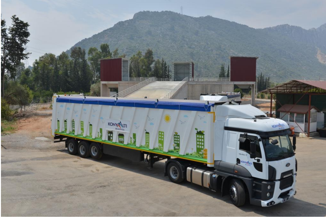
Şekil 4: Katı atık aktarma istasyonu
