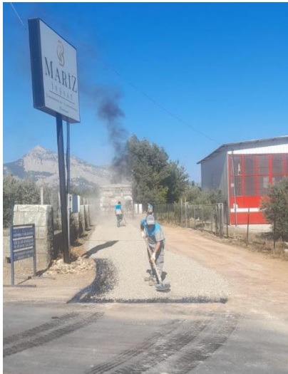
Çakırlar Mah. Papatya Sok. sathi asfalt çalışması
