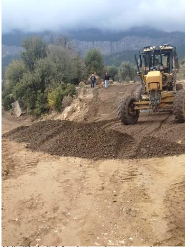
Küçükdağ Mevkii yol açma çalışması
