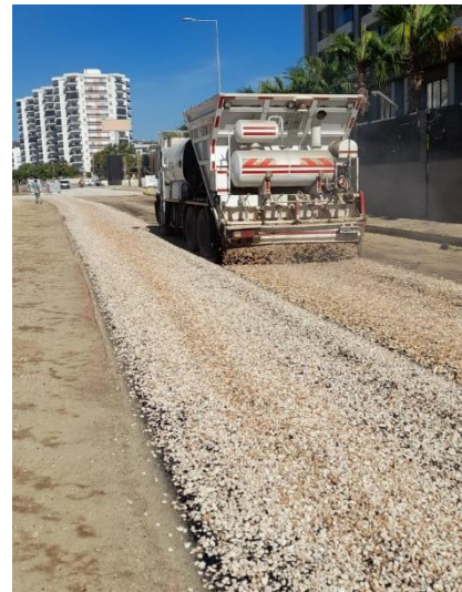
Hurma Mahallesi 297 Sok. sathi asfalt çalışması
