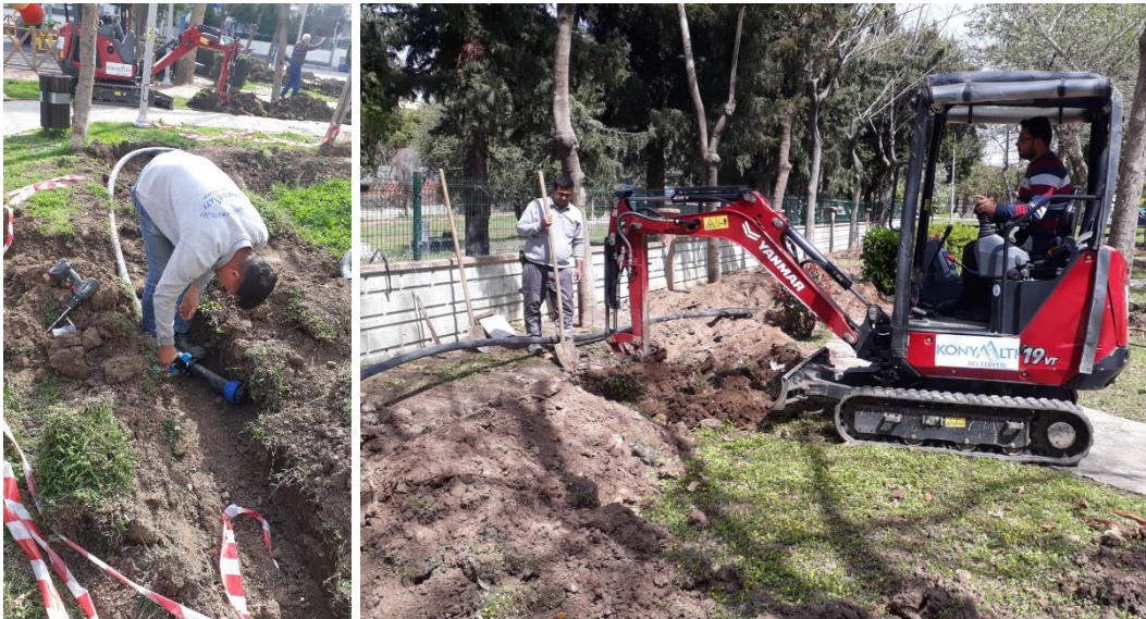
Bakım ve onarım çalışmaları
