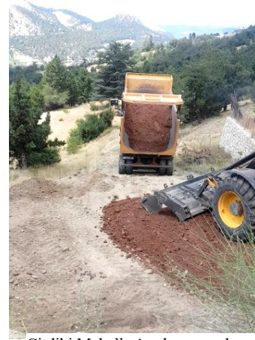
Çitdibi Mahallesi yol açma çalışması
