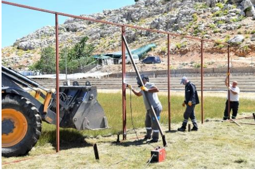
Feslikan Güreş sahası demir çerçeve yapım çalışması
