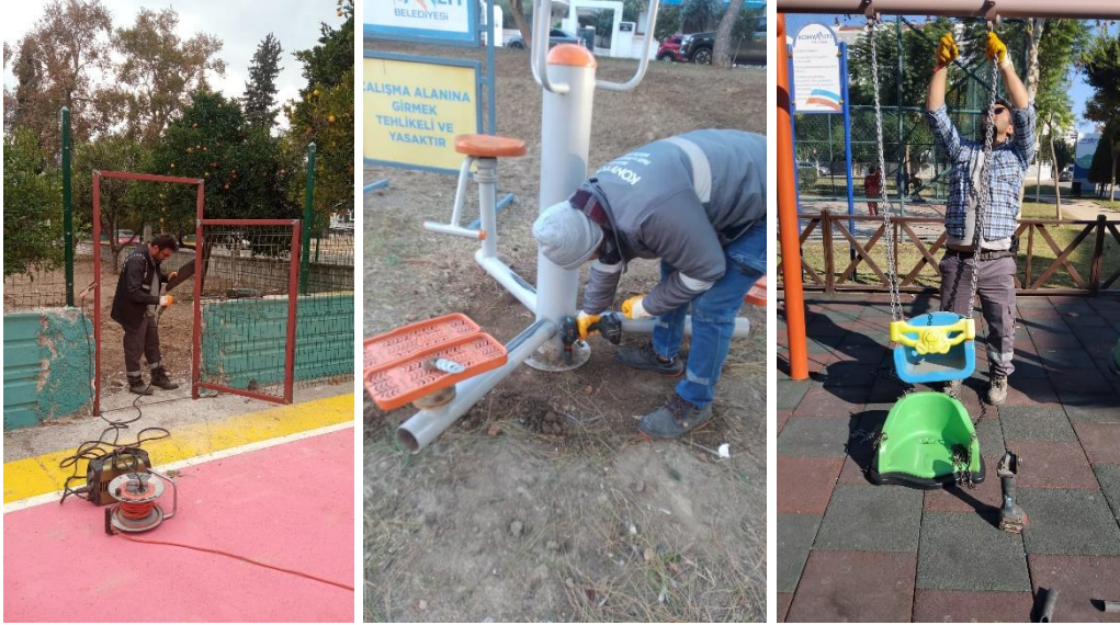
Bakım ve onarım çalışmaları
