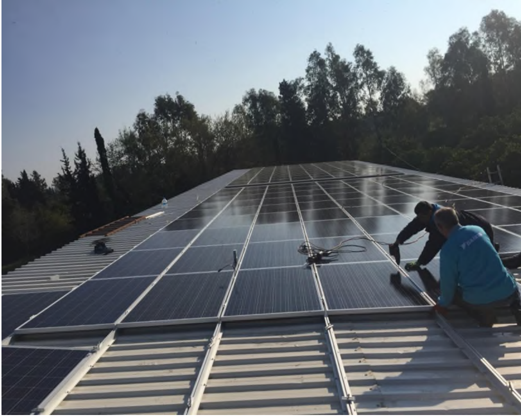
Güneş enerji santrali kurulum çalışmaları
