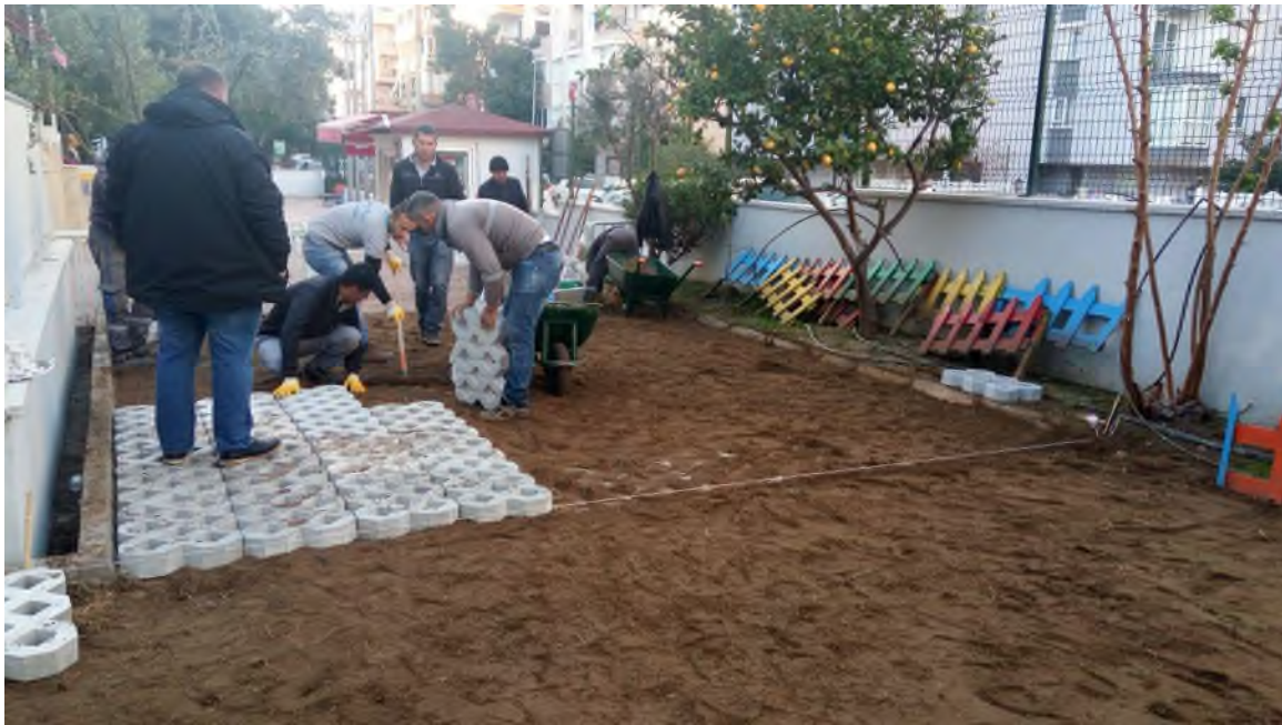
Çim taşı döşemesi.
