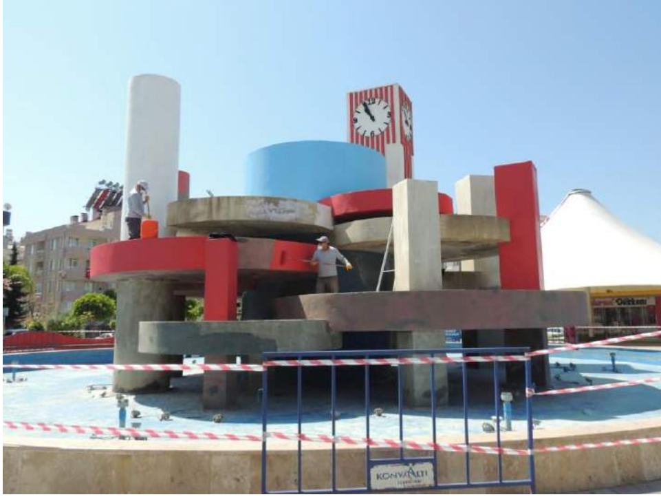
Havuz boyama çalışmaları.
