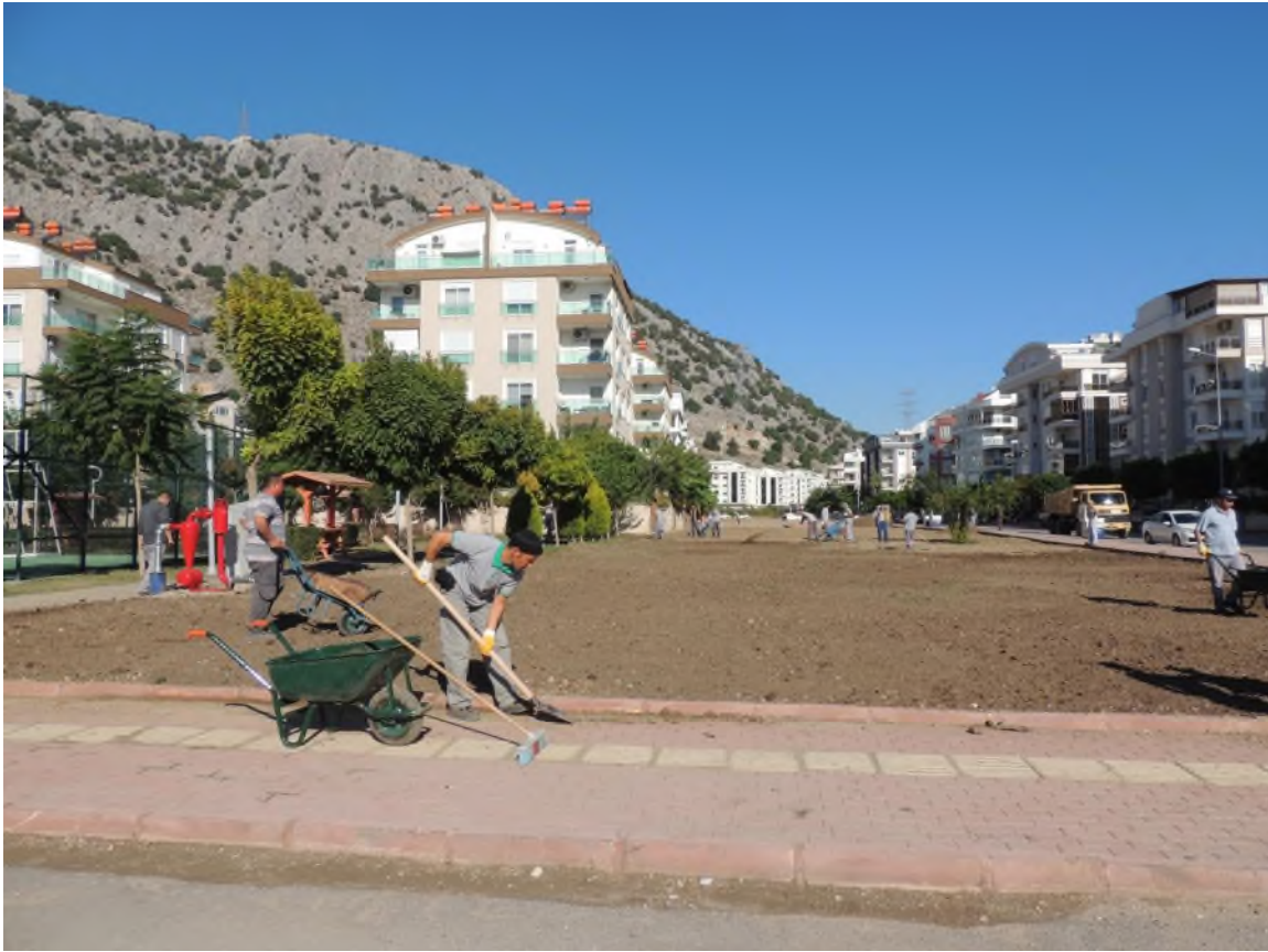
Hurma Caddesi toprak ilavesi ve tesviye çalışmaları.
