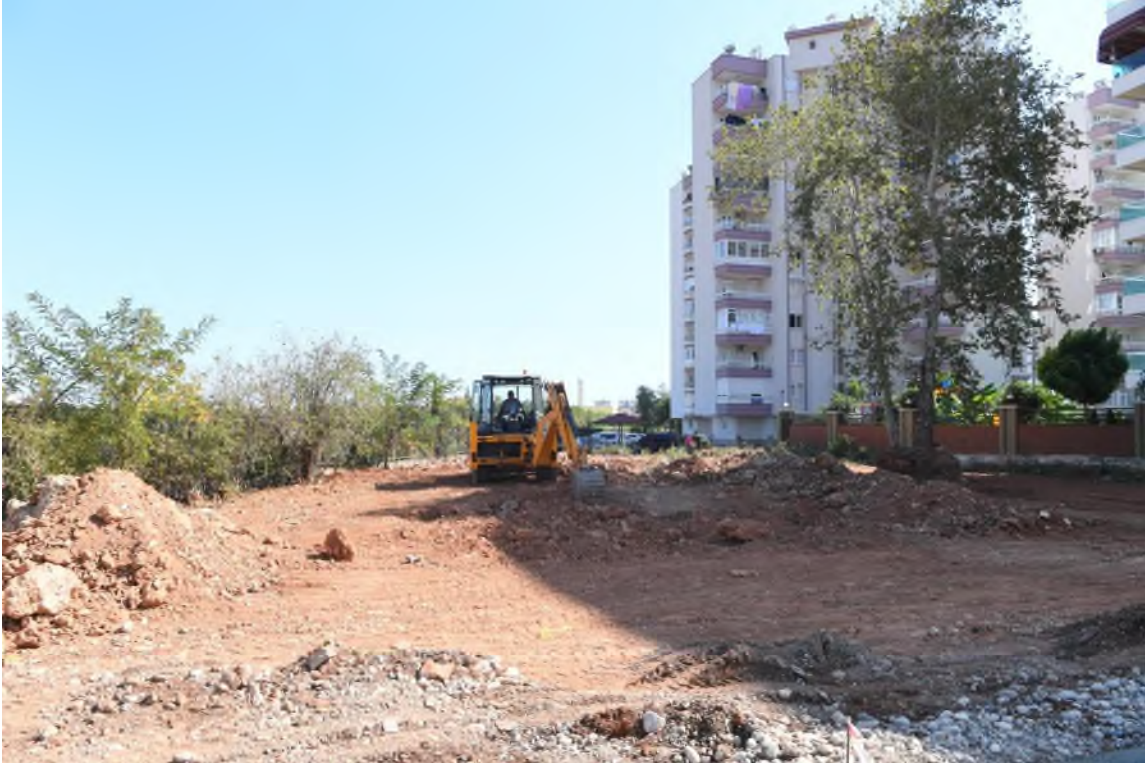
Park yapım çalışmaları.
