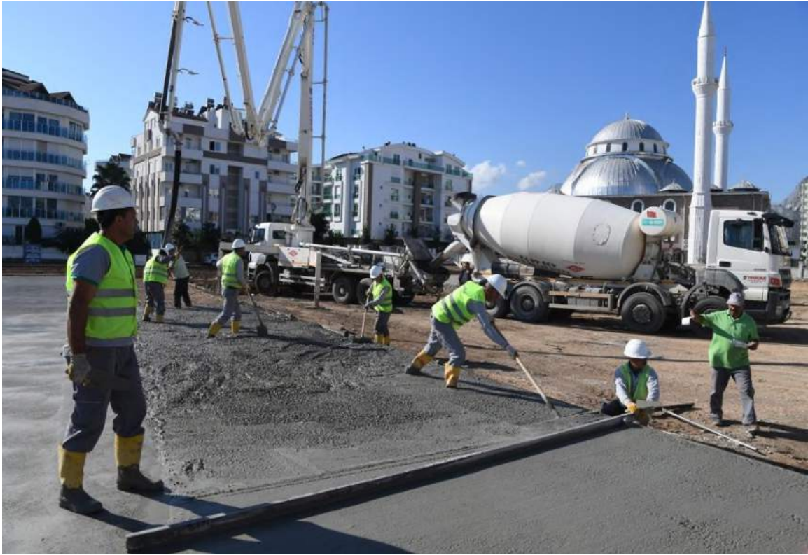
Naim Süleymanoğlu Parkı yapım çalışmaları
