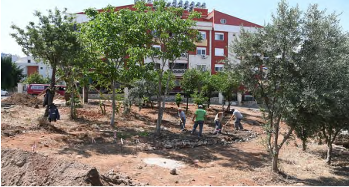
Faik Istil Parkı tesviye çalışmaları
