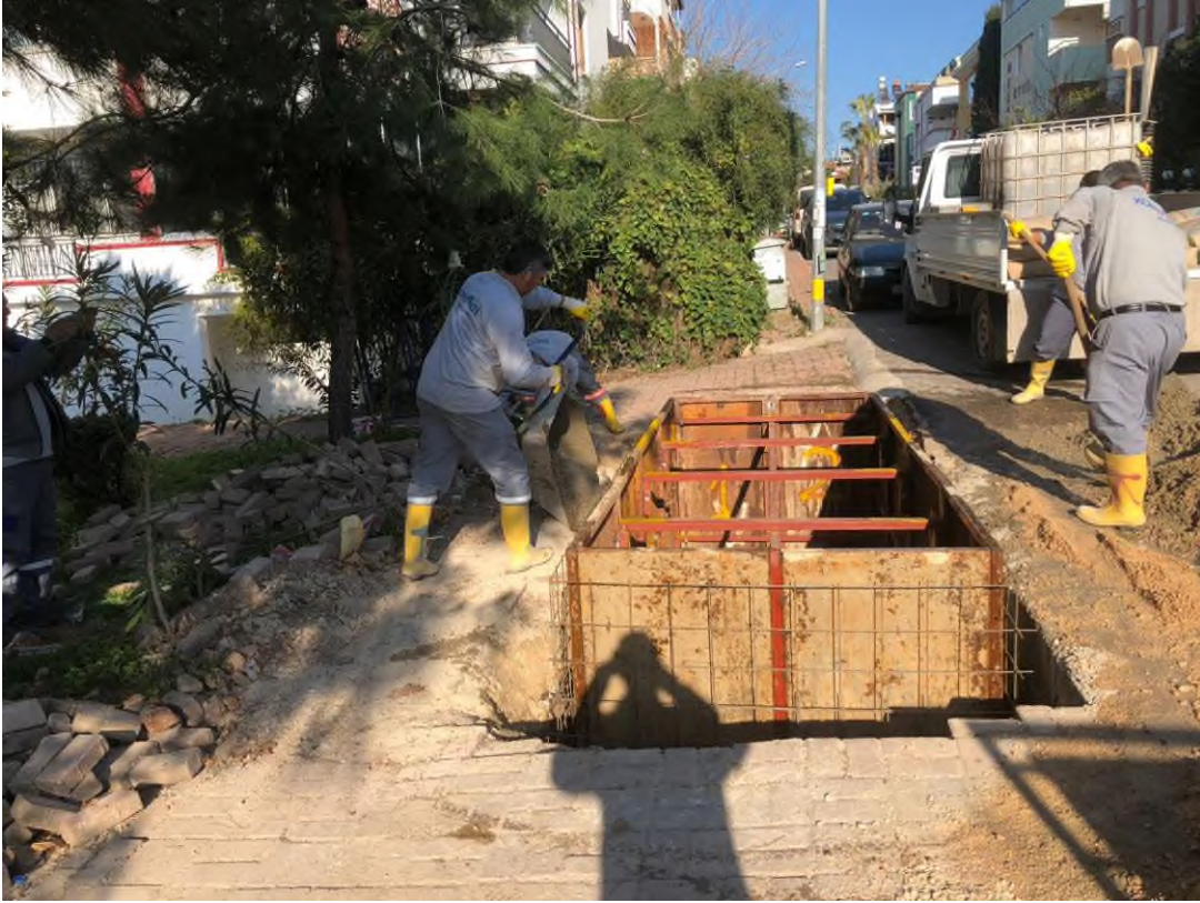
Yeraltı konteyner sistemi montaj hazırlığı
