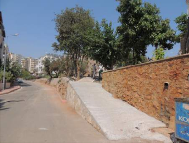
Faik İstıl Parkı istinat duvarı yapım çalışması.
