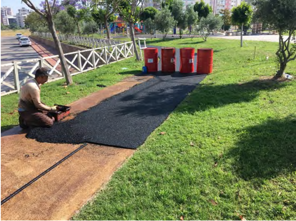
M. Karabulut Parkı'nda SBR zemin döşeme uygulaması.
