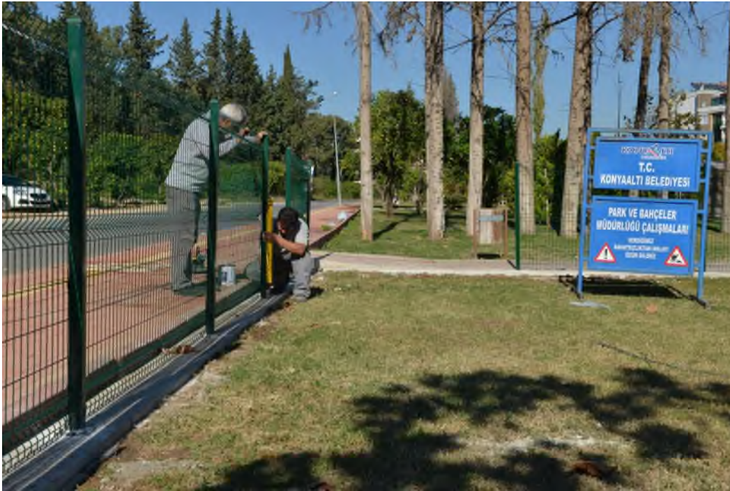
Panel çit uygulama çalışmaları.
