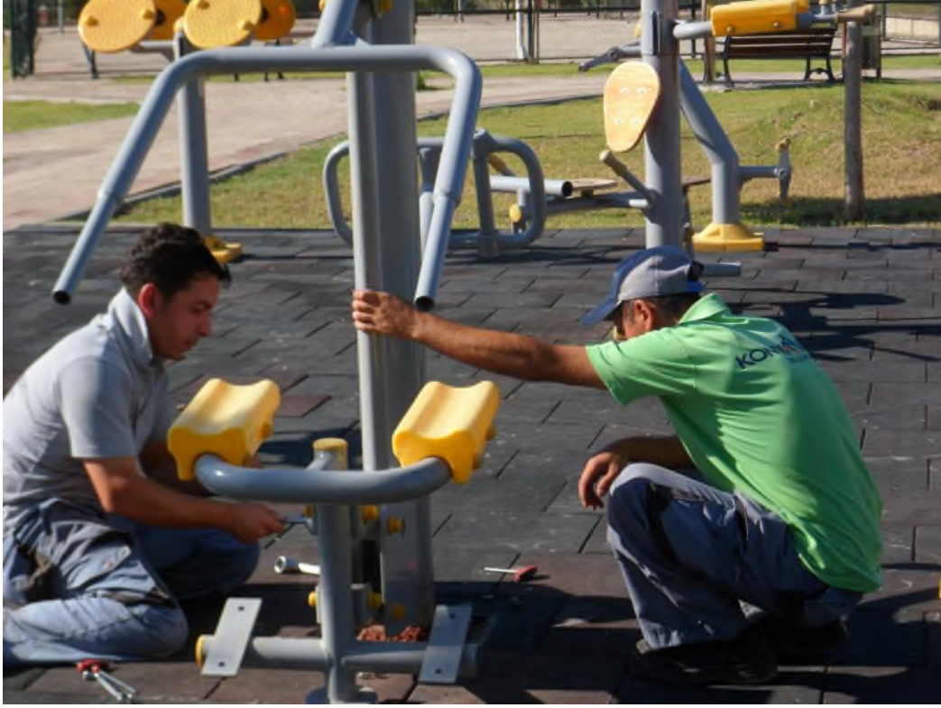
Spor aletlerinin bakım ve onarımları.
