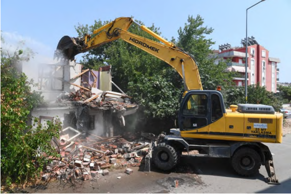
Kamulaştırması yapılan gecekondunun yıkımı.
