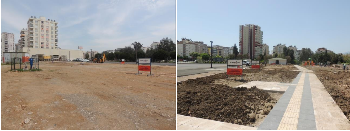
Park yapım çalışmaları
