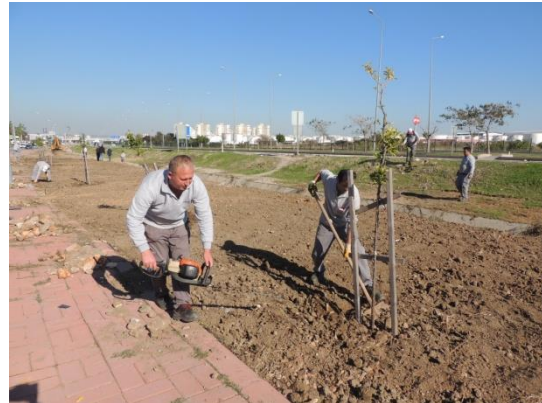
Park yapım çalışmaları
