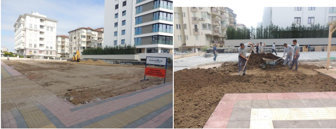
Park yapım çalışmaları
