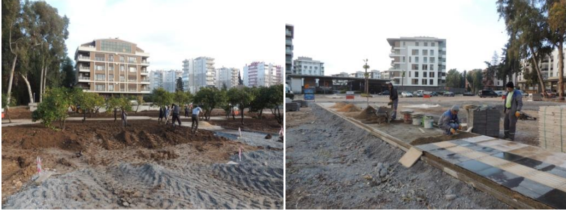
Park yapım çalışmaları
