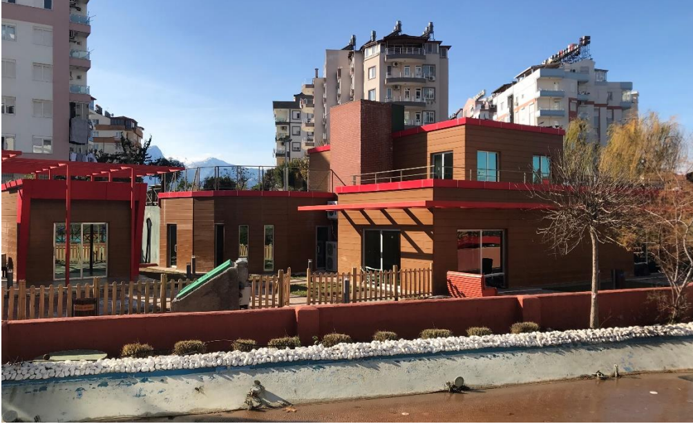
Şekil 4 Expo Park Ana Bina Tadilat Yapım İşİ
