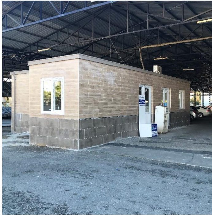
Şekil 5 Siteler Pazar Yeri Mescit Binası Tadilat Yapım İşİ
