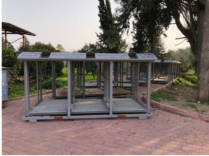
Yeraltı konteyner sistemi montaj hazırlığı
