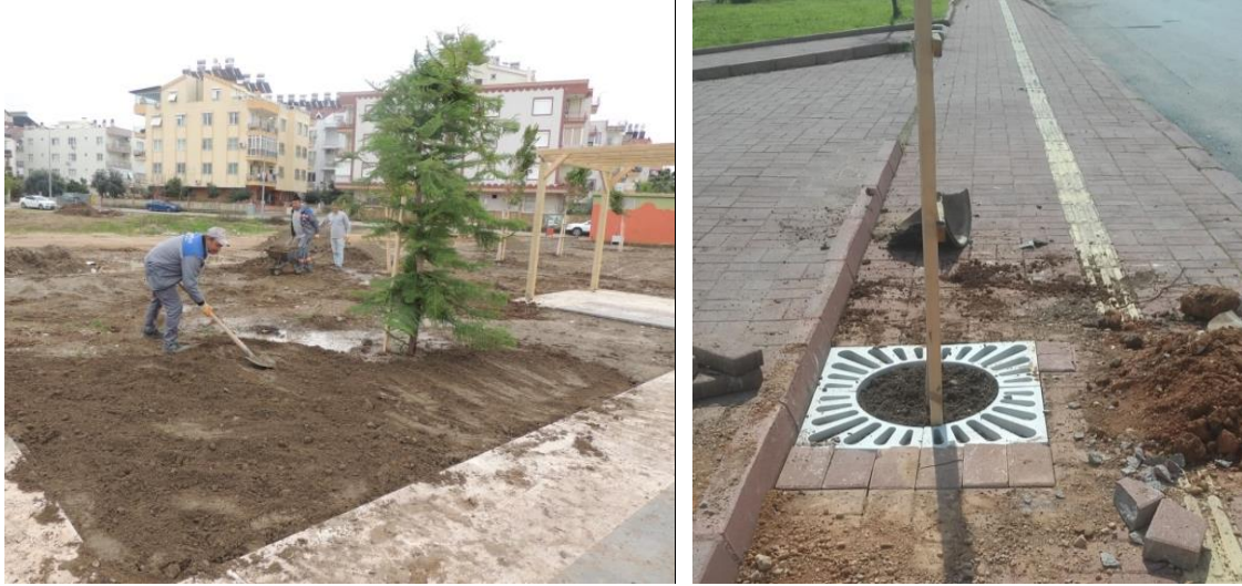
Park ve kaldırım ağaçlandırması ve ağaç dibi ızgarası uygulaması
