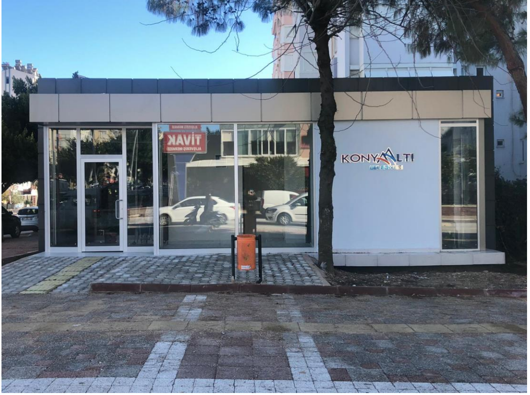
Şekil 2 Gürsu Mahallesi Belediye Hizmet Binası Yapım İşi
