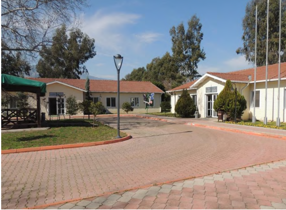
Park ve Bahçeler Müdürlüğü İdari Bina ve Teknik Büroları
