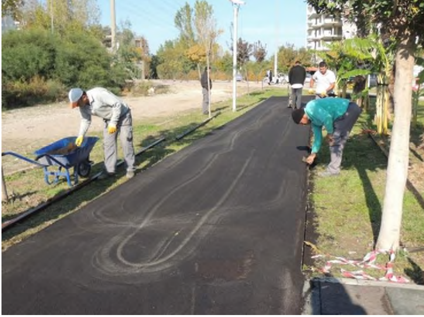
Hurma Mahallesi Hurma Parkı yürüyüş yolu yenilme çalışması
