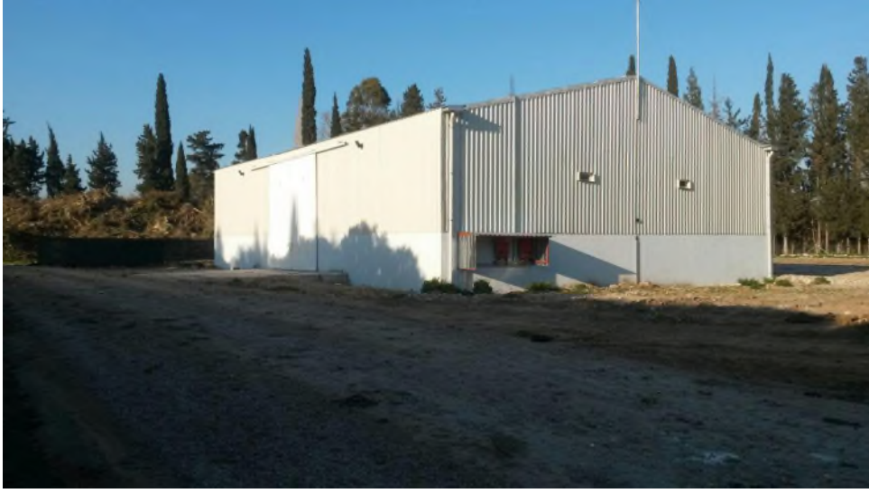
Atık getirme tesisinin dıştan görüntüsü.
