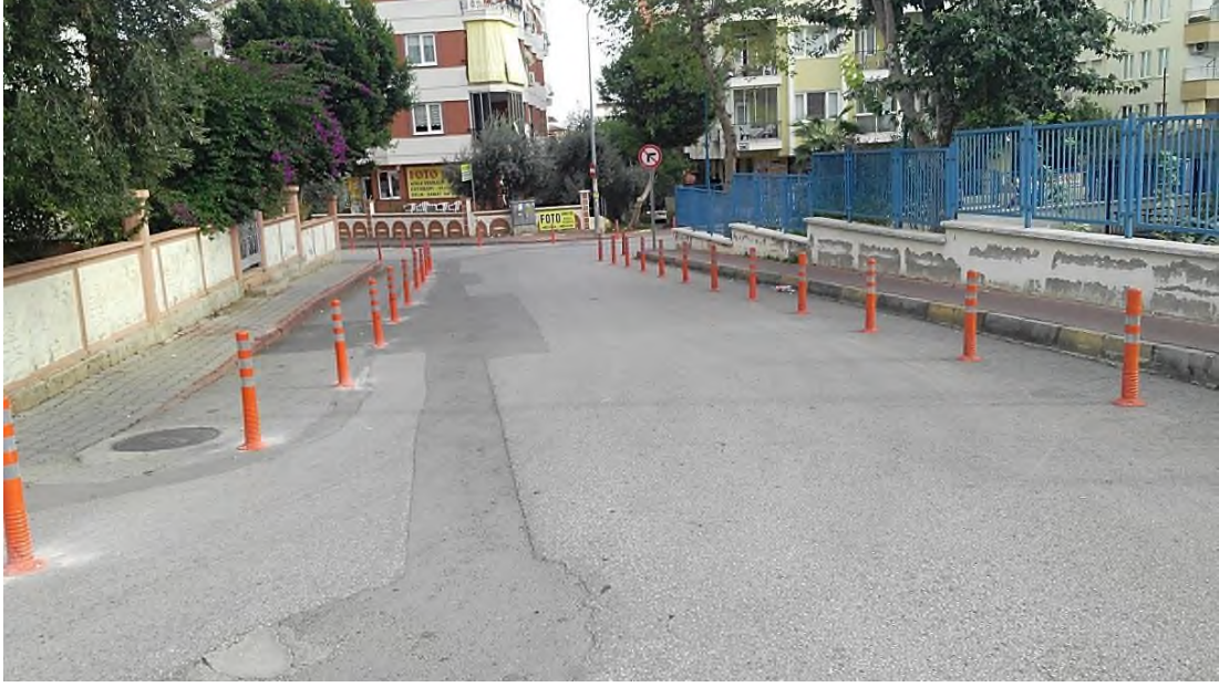
Konyaaltı Kaymakamlığı Binası etrafına, güvenlik nedeniyle delinatör çakılması.
