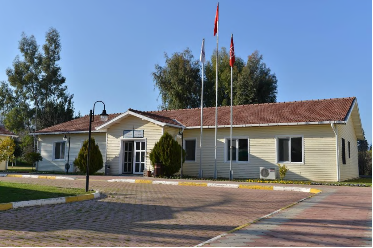
Fen İşleri Müdürlüğü ve Park Bahçeler Müdürlüğü Hizmet Binası
