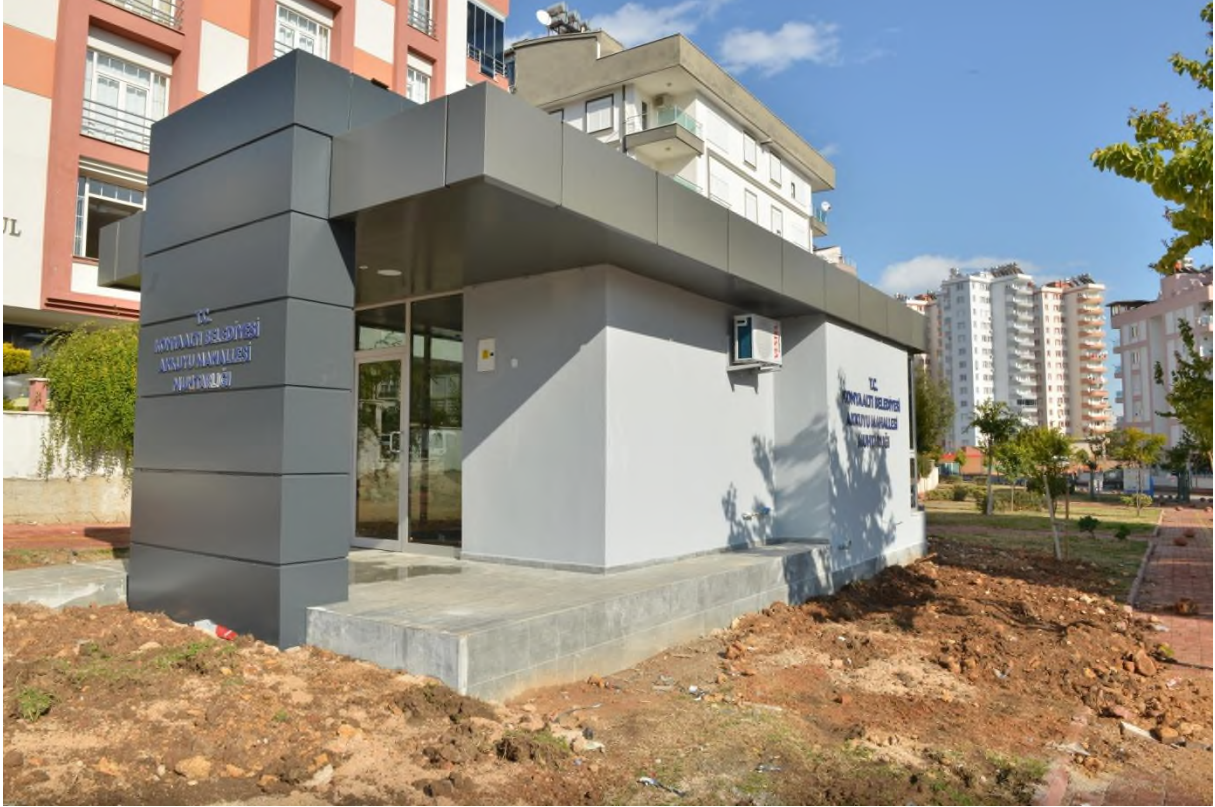
Akkuyu Muhtarlık Binası
