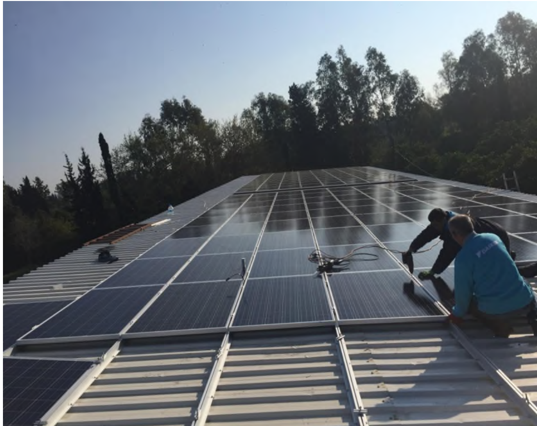
Güneş enerji santrali kurulum çalışmaları
