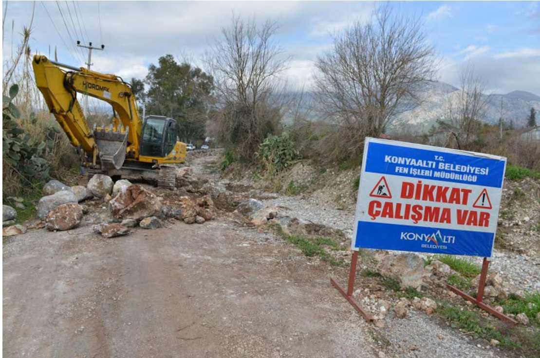
Karatepe Mahallesi Borualtı Caddesinde 150 metre uzunluğunda taş tahkimatı yapılmıştır.
