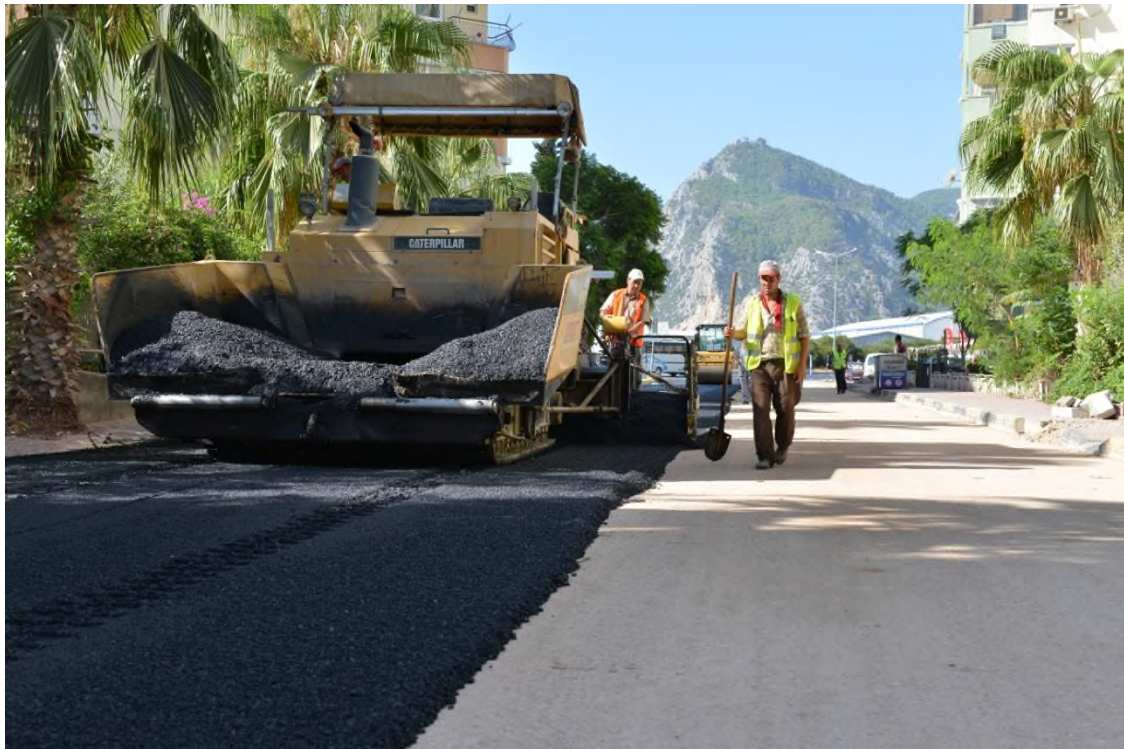
Sıcak Asfalt Kaplama Çalışmalarımız
